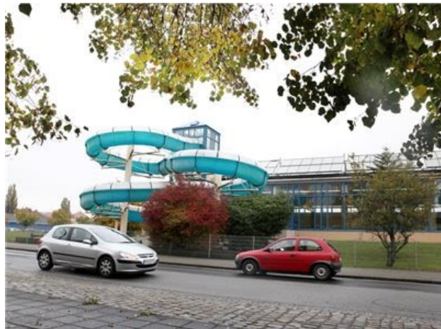
Das Hallenbad in Kamenz ist derzeit wegen Havarie geschlossen.
